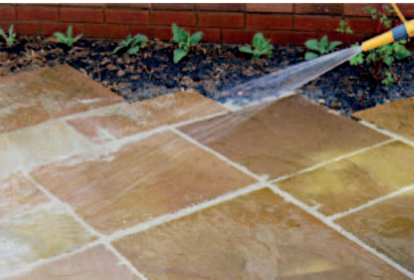
Bild 5: Pflastersteinoberfläche mit viel Wasser gründlich abspülen
