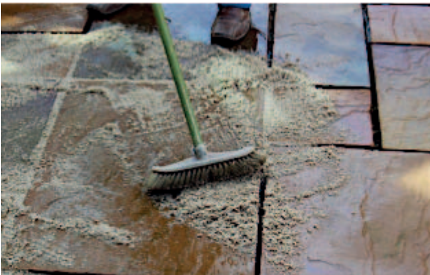
Bild 2: Fugenmörtel sorgfältig diagonal in die Fugen einkehren
