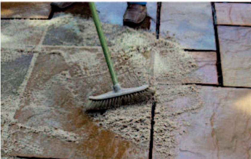
**Bild 2:** Fugenmörtel sorgfältig diagonal in die Fugen einkehren
