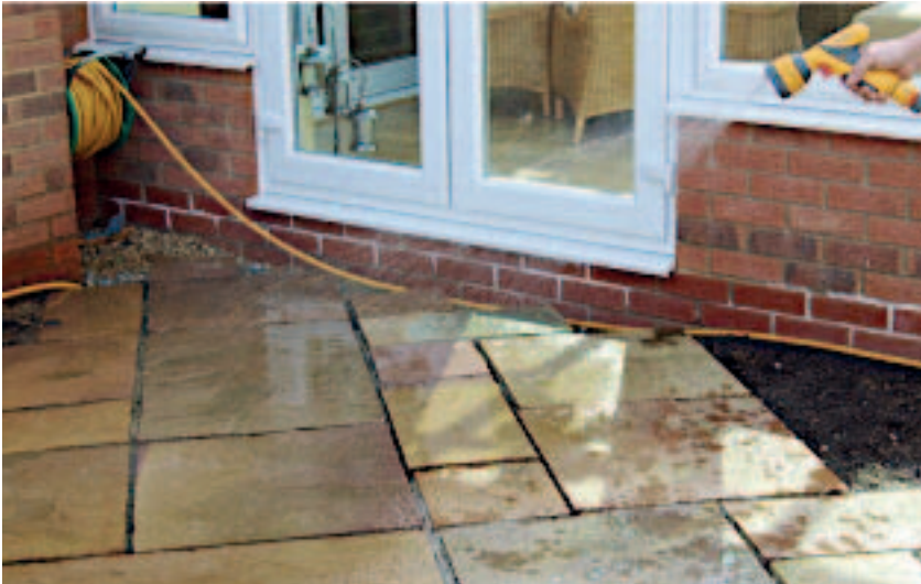
Bild 1: Fläche mit viel Wasser gründlich vorwässern
