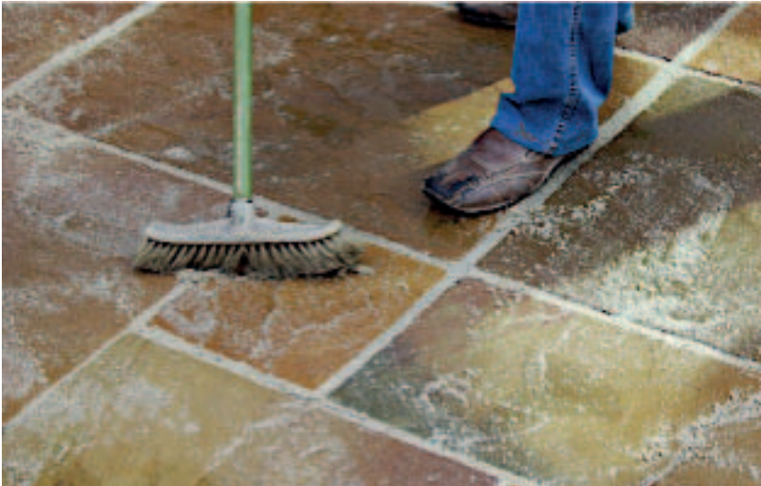
Bild 4: Fugen mit einem Besen immer wieder auffüllen und Fläche reinigen
