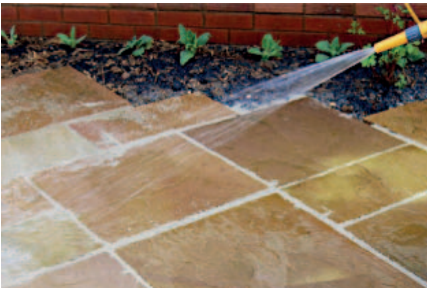
Bild 5: Pflastersteinoberfläche mit viel Wasser gründlich abspülen
