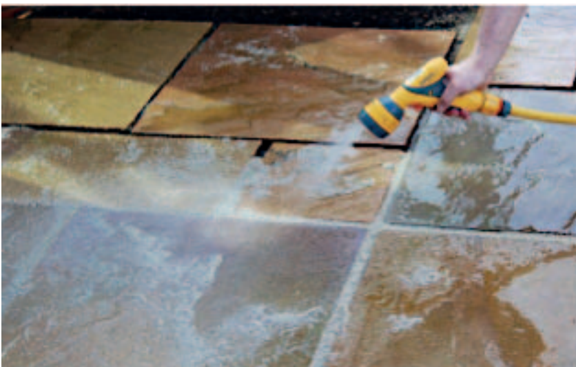
Bild 3: viel Wasser verwenden und Fugenmörtel mit Wasser verdichten
